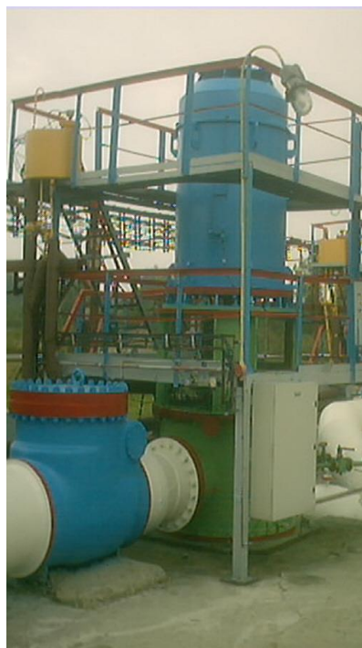
Рис. 14 – Подпорный вертикальный насос типа НПВ
