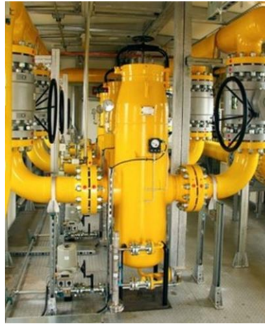
Рис. 38- Газорегуляторный пункт.
